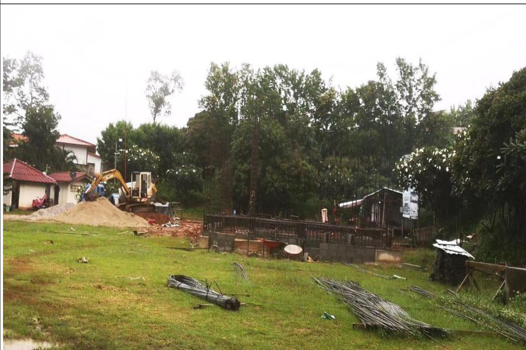
2020年10月一层的柱子已浇筑混凝土了。上二层的钢筋。
