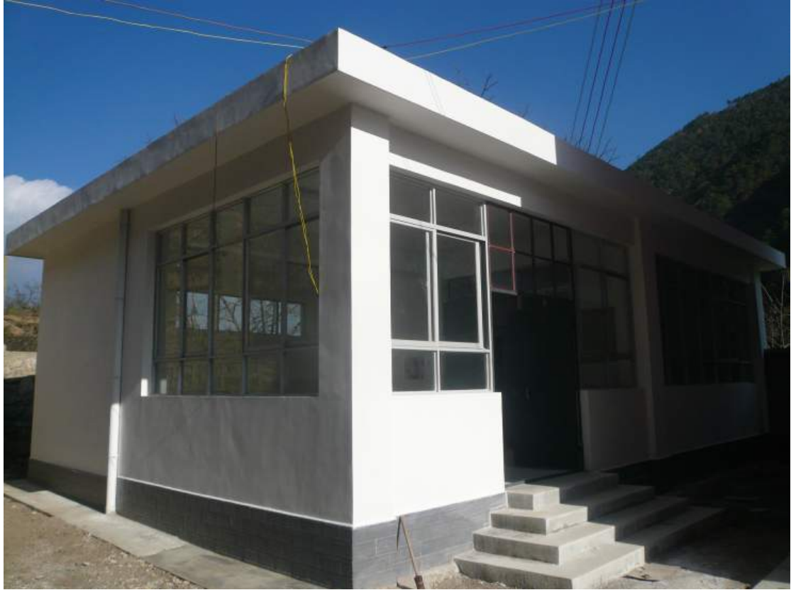
上圖：同時竣工之食堂；下圖：從下邊眺望教學樓和宿舍樓。
