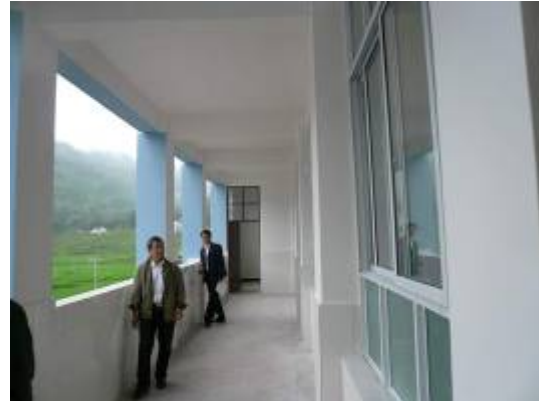
宿舍二樓走廊
