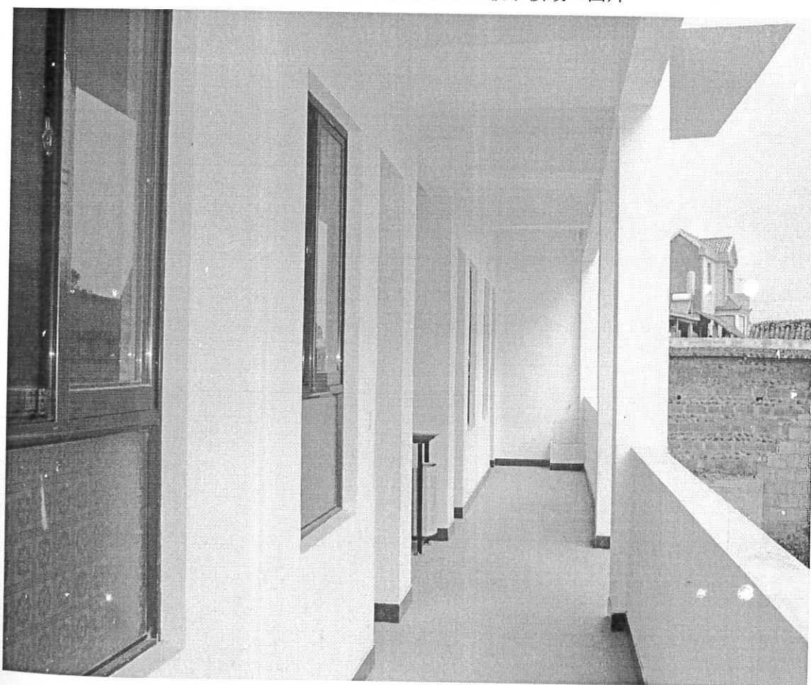
泸西县旧城镇乐业小学黄家乐爱心教学楼竣工图片
