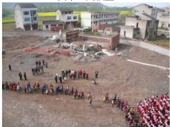
俯瞰操場，圍牆內在建的是食堂，其後方長型建築物是舊校舍
