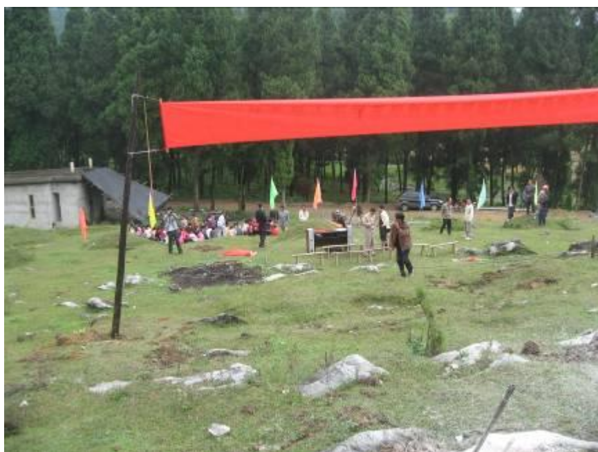
校址上多土壤和石頭，現剛動土興建
