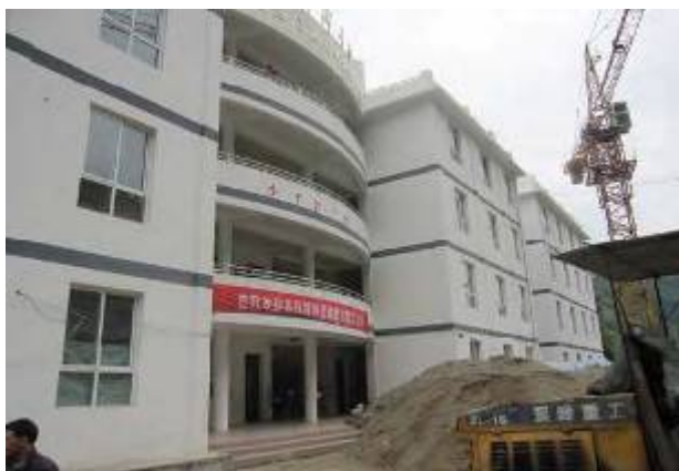
新教學樓前空地正在平整
