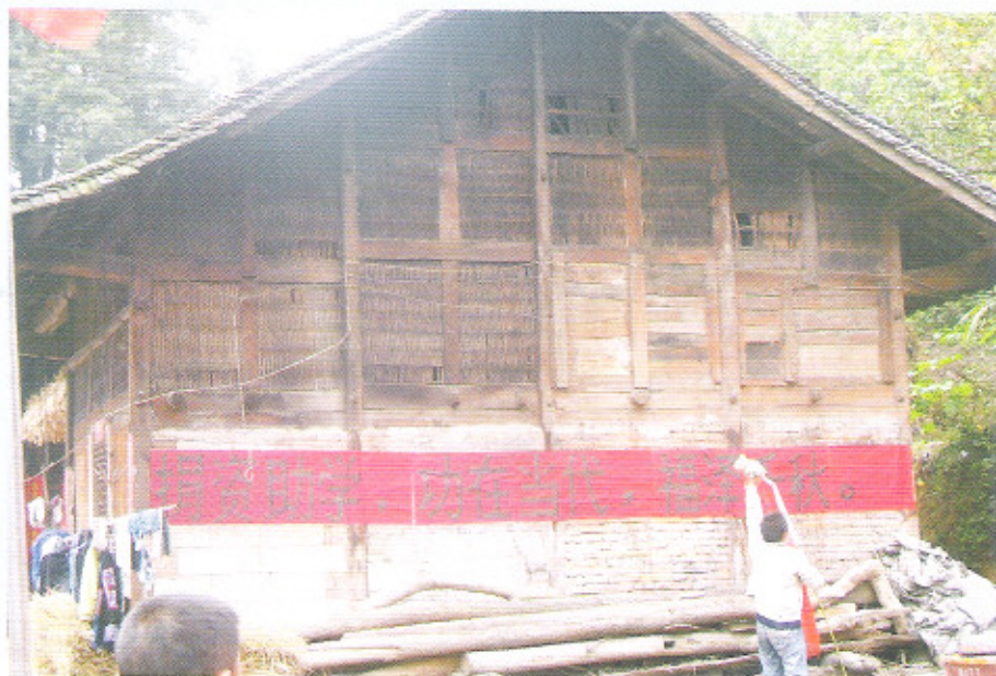
贵定县新铺乡赖子井小学老教学楼
