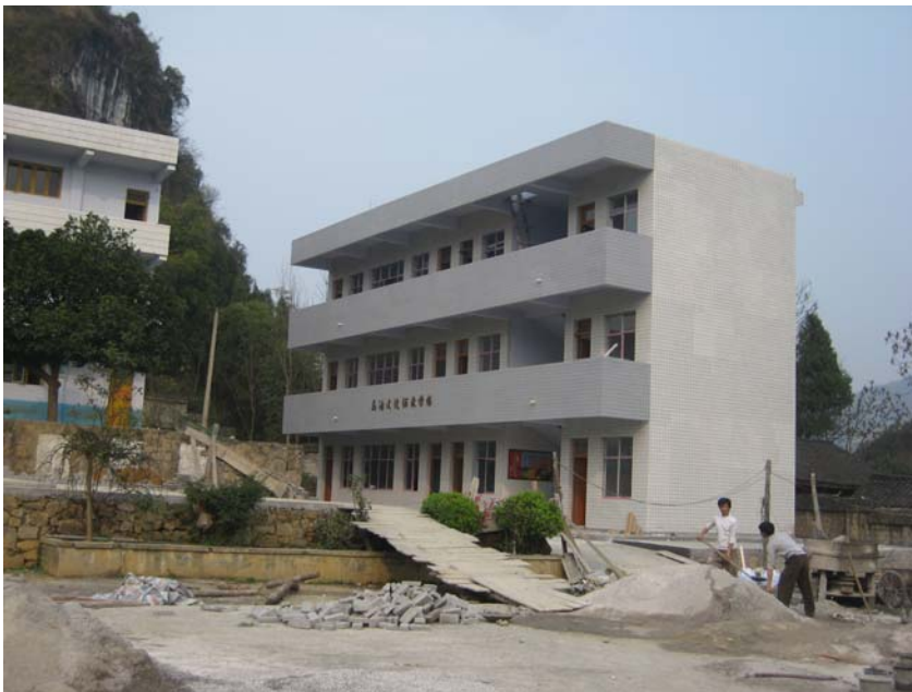
2009年3月18日 工程大致完成
