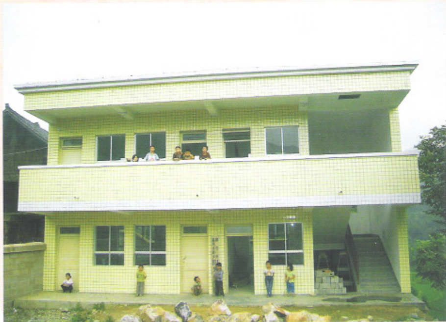
都匀市基场乡阳光小学新教学楼
