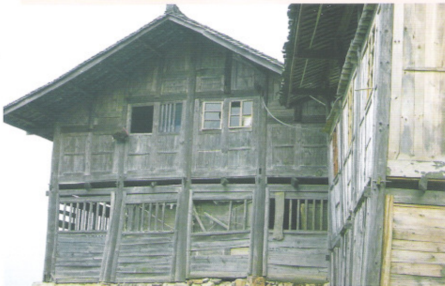
都匀市基场乡阳光小学教学楼旧貌
