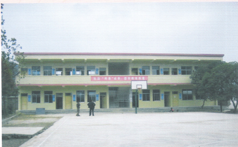
都匀市墨冲镇新州小学新教学楼全景
