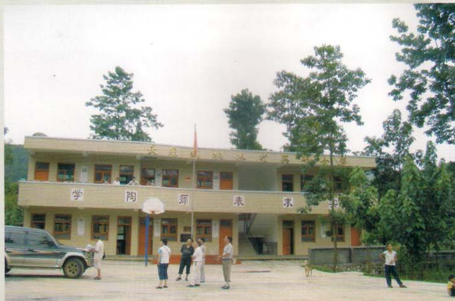
长顺县长寨镇桐木小学新教学楼
