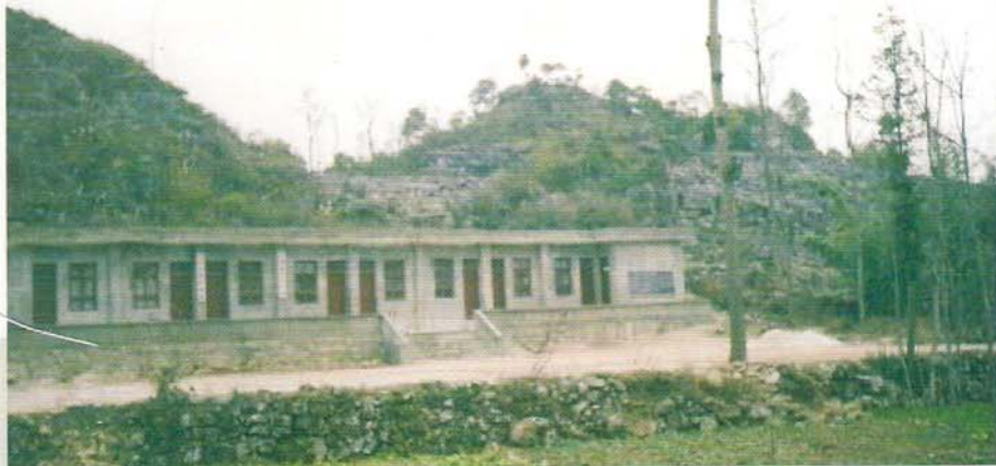
长顺县长寨镇桐木小学老教学楼
