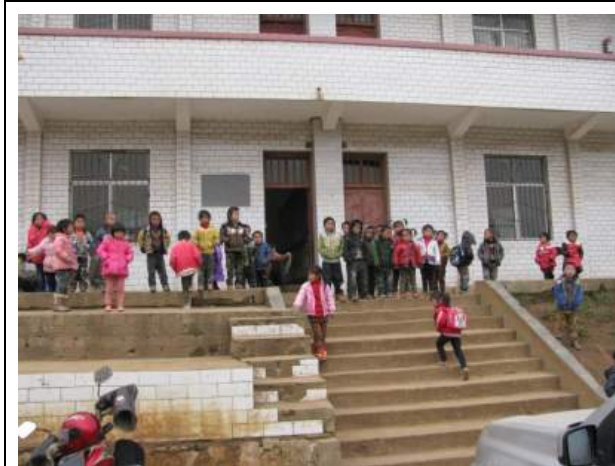
上：恩暉教學樓近景
