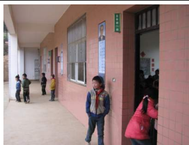
上：2009年建教學樓近景
