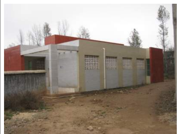
上：新建的學生廁所
