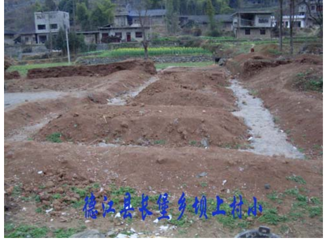
2008年3月31日地基工程
