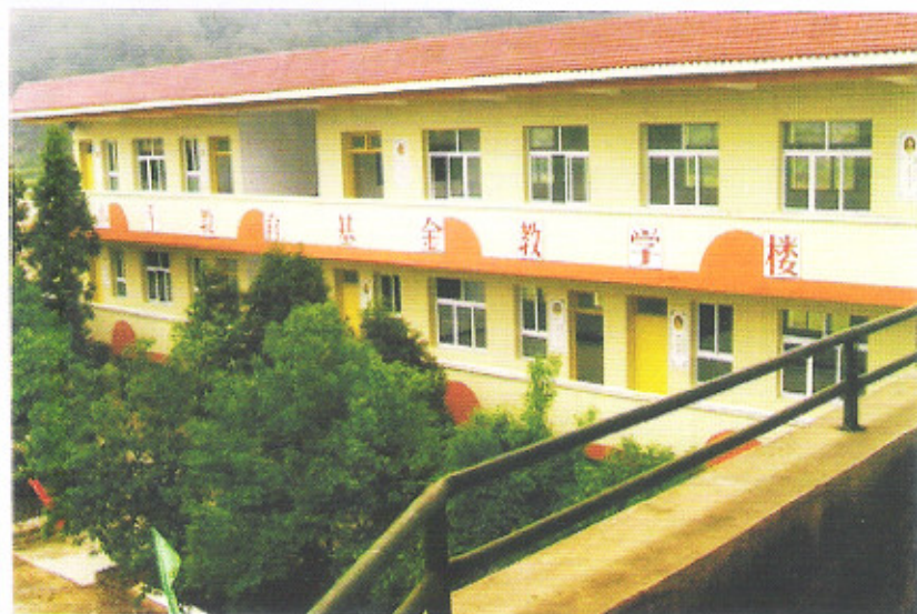
贵定县昌明镇小场小平中学新教学楼
