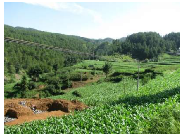
新增設施工地
