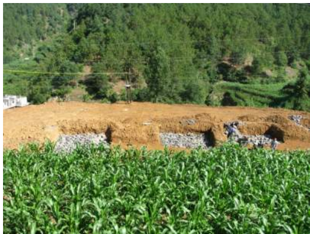
新增設施工地
