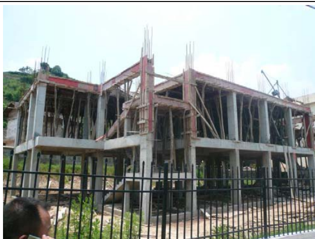
在建的宿舍樓
