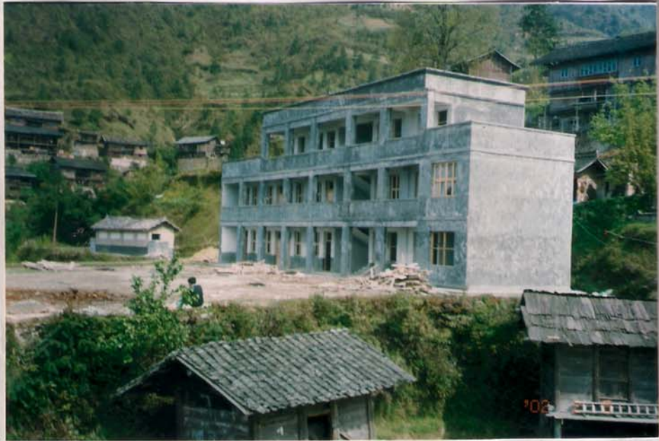
已建成的排里小学教学楼
