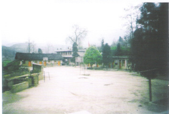
贵定县落北河乡宝山小学老教学楼
