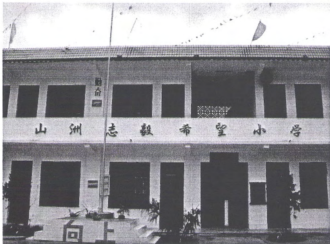
上图为逻沙乡山洲志毅希望小学教学楼正面
