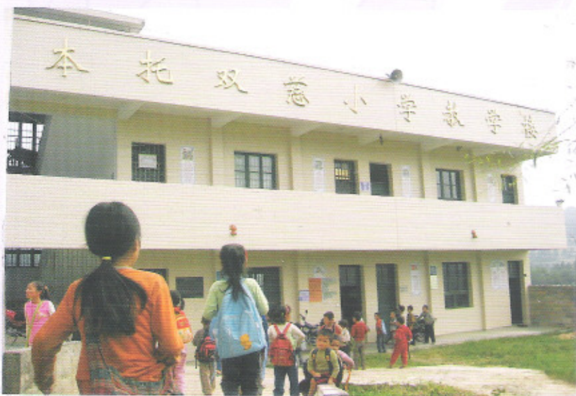
三都县廷牌镇本托双慈小学新教学楼
