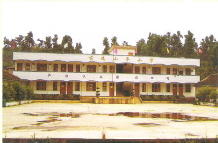
福泉市高石乡前进小学教学楼新貌
