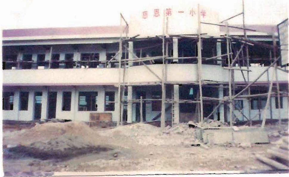
主体全部竣工
