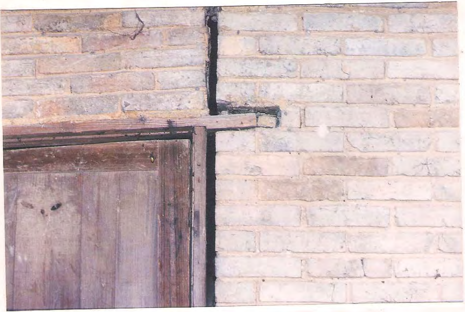
图四：崩裂欲塌的 60 年代修建的学生宿舍，似乎隐含着不尽的沧桑
