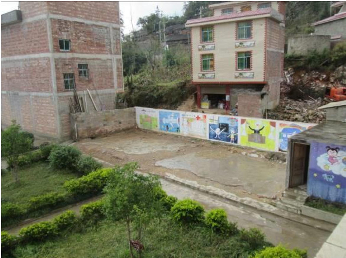
危房拆卸後的空地
