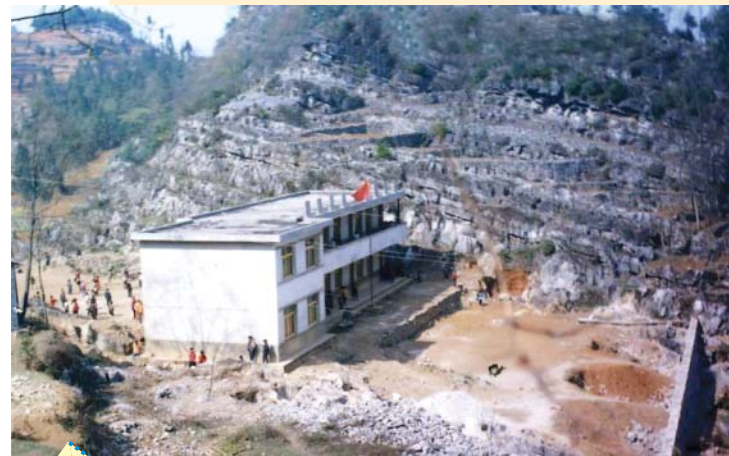
操場正在施工中。
